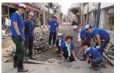
復旧作業の様子
