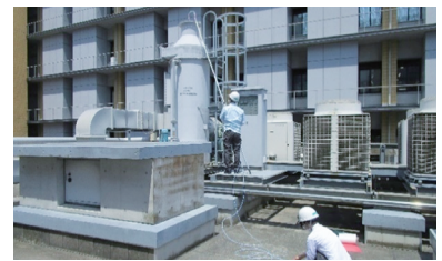
屋上に設置の排ガス処理装置(スクラバー)出口における排ガス測定の様子
