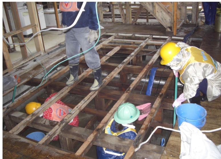
床下のヘドロ出し（宮古市）
