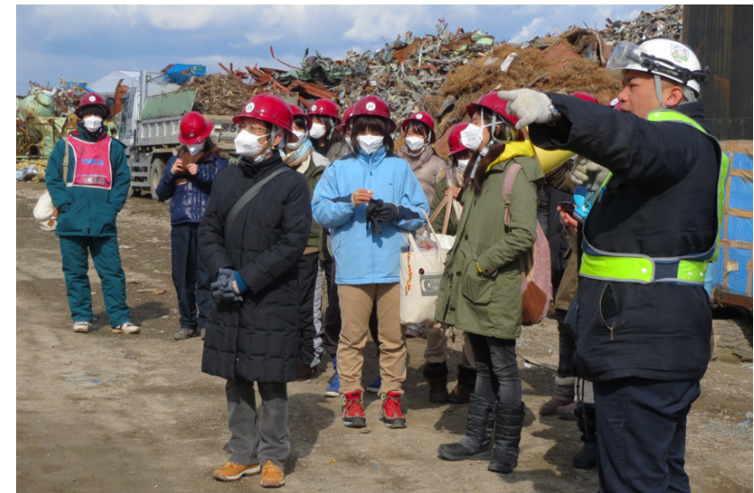
瓦礫処理作業現場見学
