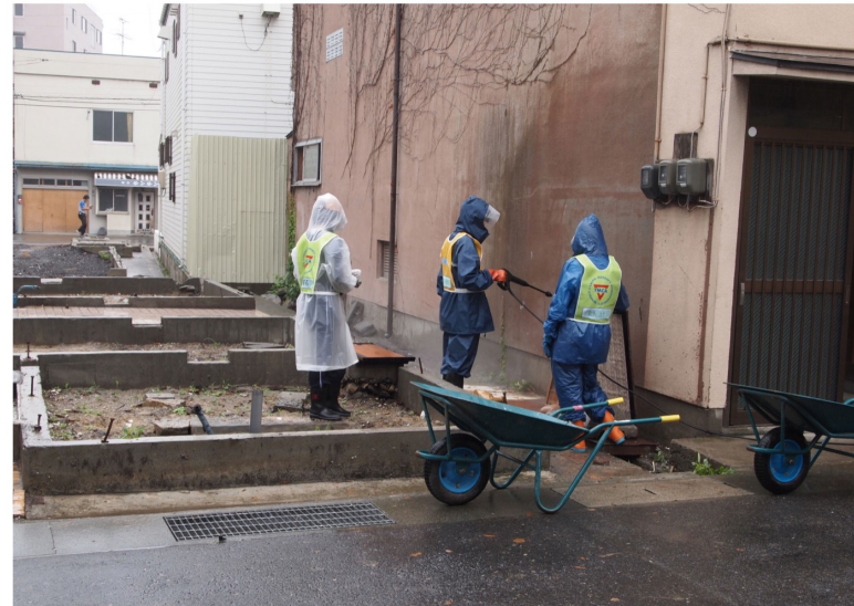
高圧洗浄機で壁の洗浄（宮古市）
